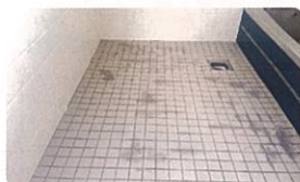
タイルひび割れ等の下地調整
